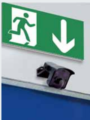
Radaros érzékelő a menekülési irányban, alapkivitelben
