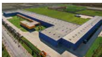
Hörmann Tianjin, Kína
